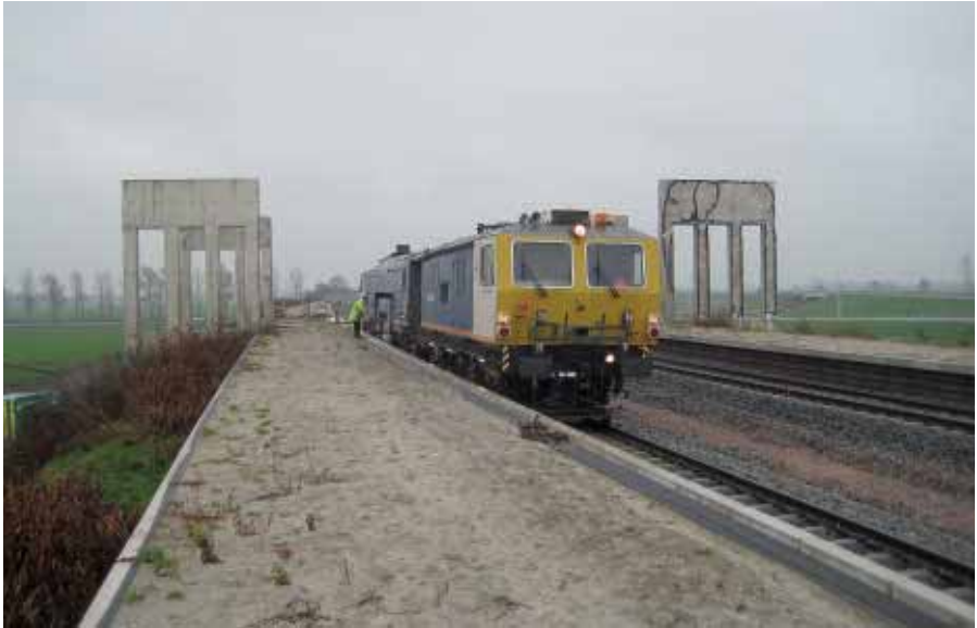
Kampen, 2 november 2011. De stopmachine die zorgt dat het spoor op de juiste plek en goede hoogte komt, staat stil bij station Kampen Zuid. Op de rechter betonnen pijler is de in de zomer 2010 geschilderde olifant te zien. (Foto: K. Haar).
