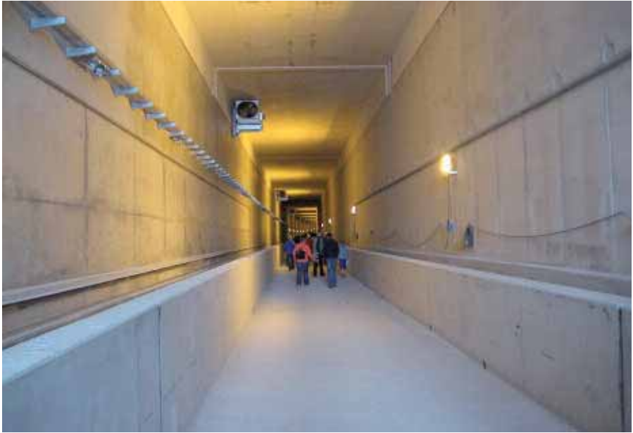
Drontermeertunnel, 6 juni 2009. De vrijwel voltooide tunnel tijdens de De Dag van de Bouw, praktisch gereed voor het leggen van de sporen en bedrading. (Foto: K. Haar).
